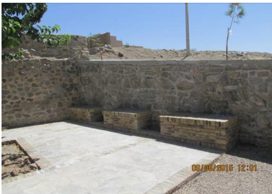
اجرای دیواره سنگی همراه با سکوی نشستن و کفسازی محوطه آسیاب قرائی
