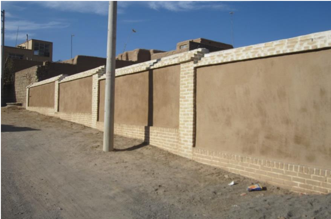
مرمت دیواره رختشورخانه
