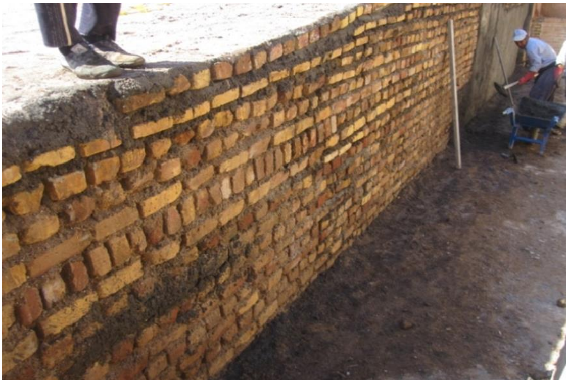
مرمت دیوار رختشورخانه
