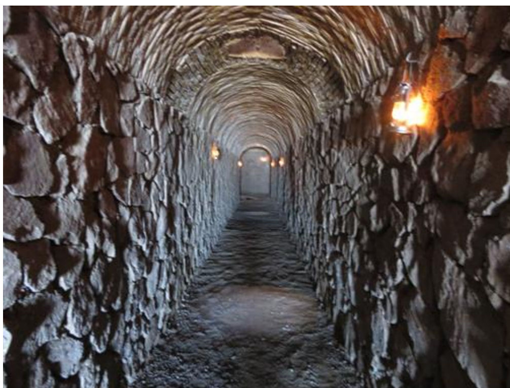
اجرای مسیر دسترسی به پایاب یکی از میل چاههای کاریز گرم
