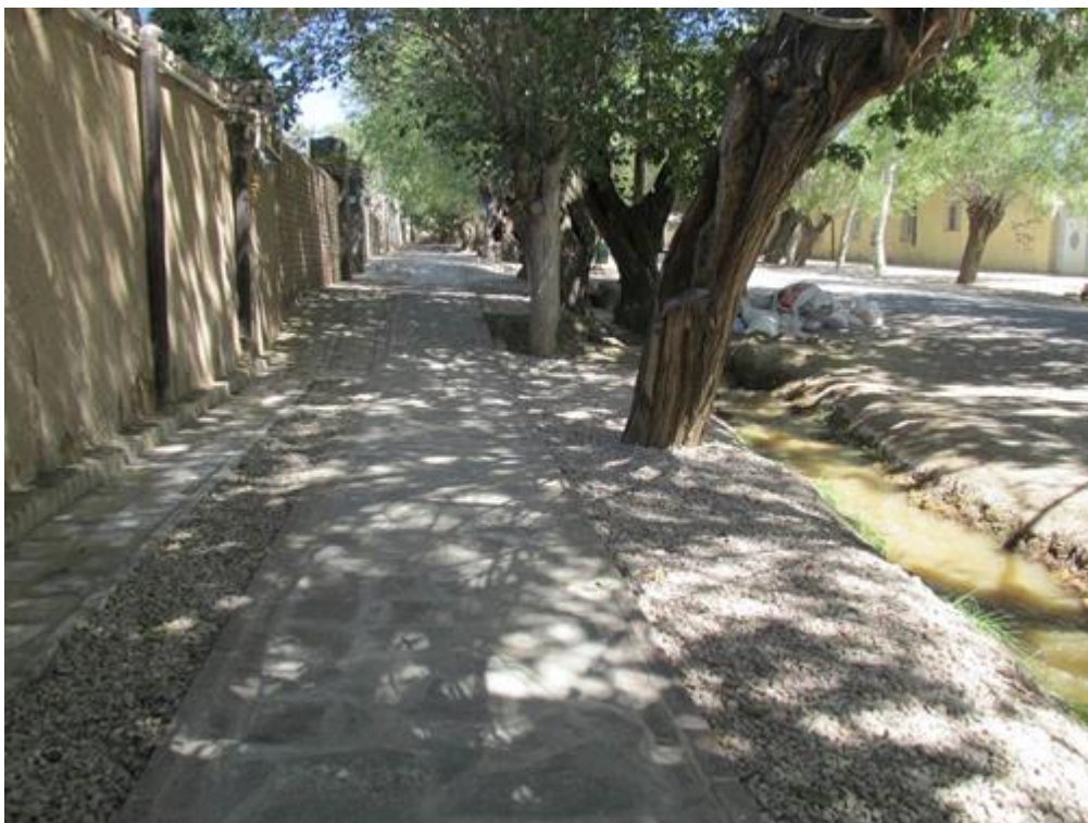
اجرای کفسازی ترکیبی در معابر دو طرف جوی بلده
