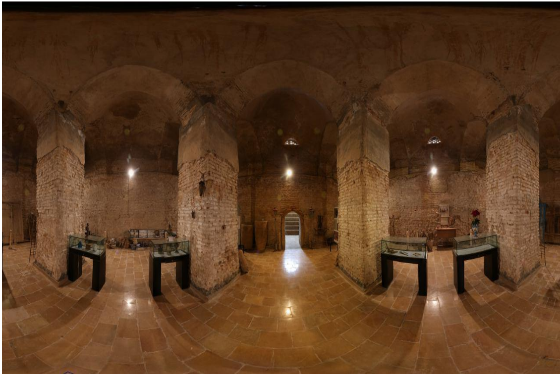
کف سازی داخل آب انبار
