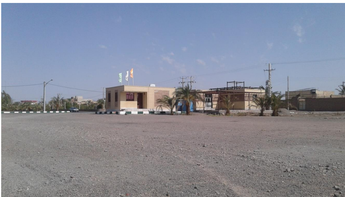
احداث دو ساختمان در محل قنوات ثبت جهانی اکبرآباد و قاسم آباد
