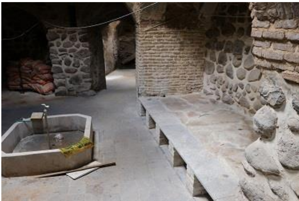
کف سازی داخل حمام
