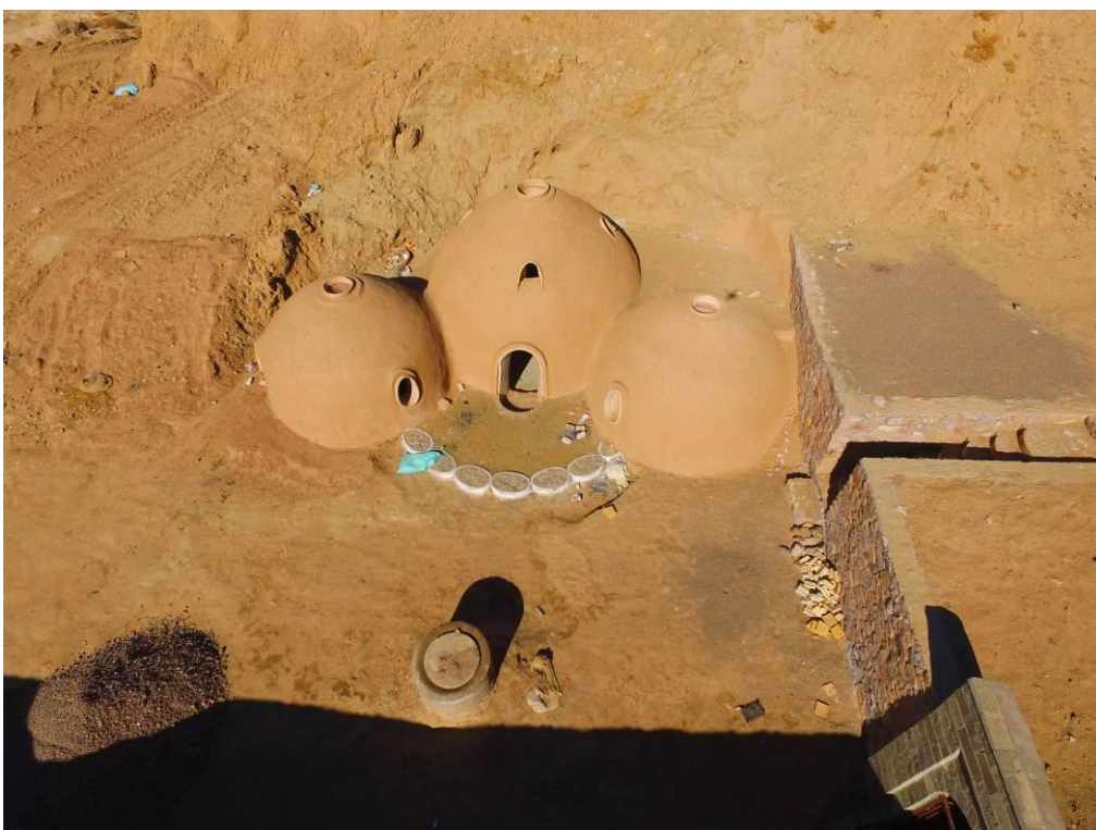
اجرای مردخانه با سیستم سازه های ابرخشت در مجاورت پایاب کاریز گرم
