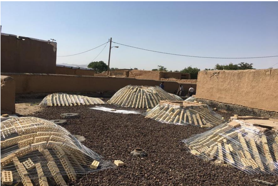
سبک سازی بام حمام و عایق کاری مجدد آن
