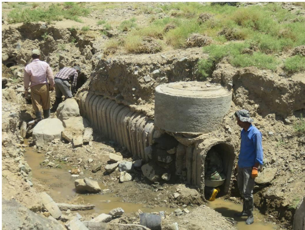
تخلیه آوار داخل کول ها و تعویض کول های شکسته و مرمت آن - کوره کاریز زنه
